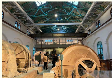
旧端出場水力発電所
