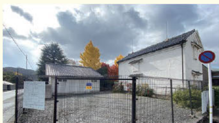
解体前の土蔵（右）と屋外倉庫
